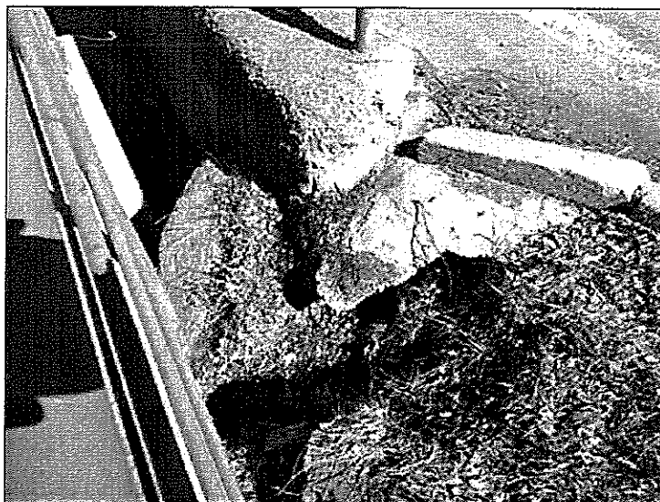
Eroze zemního tělesa na koncích říms
